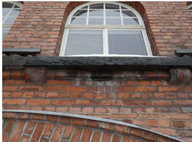
Yleiskuva Koskisiiven eteläosasta Patosillan kohdalta. Kuvassa näkyy kivistä tehtyä palkkirakennetta. Oikeassa kuvassa kiven sauma vuotaa ja kastelee paikallisesti julkisivua.
