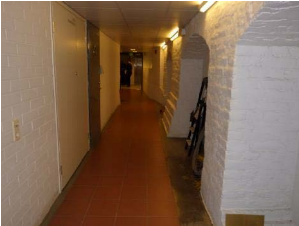
Yleiskuvia pohjakerroksesta. Kuvissa näkyy massiivitiilimuurattuja kantavia rakenteita.
