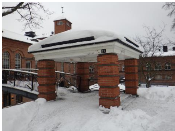
Yleiskuva (vas) puistosiiiven viereiseltä kulkuväylältä. Rakennuksen sisäänkäyntien yhteydessä on betoni- ja kivirakenteisia portaita sekä metallirakenteisia kaiteita ja lippoja. Kuva betoniportaassa on paikallisia vaurioita. Kuvan taustalla näkyy L-portaan teräspalkkisilta. Oikeassa kuvassa sillan edustalla oleva katos, jonka puurakenteisten kaiteiden ja alakaton maalipinnat ovat kuluneet.
