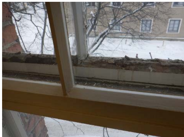
Ikkunoiden ulkopuitteiden ja karmien maalit hilseilevät yleisesti. Kuvat A-lohkosta.
