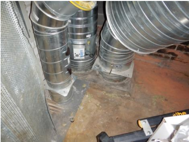
Palopeltejä ei ole ankkuroitu lattiaan.
