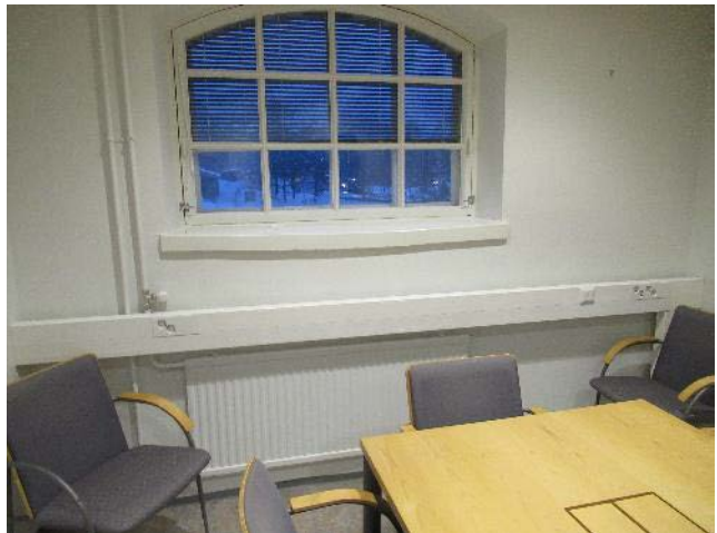
Johtokanava-asennusta.
