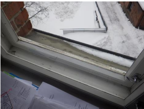
Ikkunoiden ulkopuitteiden ja karmien maalit hilseilevät yleisesti. Kuvat A-lohkosta.
