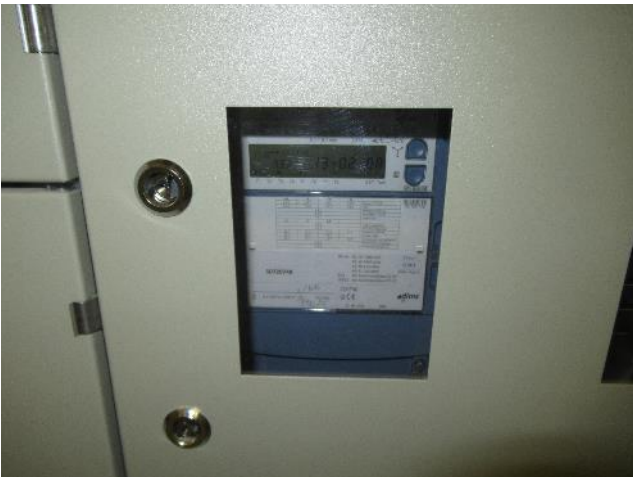
Jakeluverkkoyhtiön energiamittaus.
