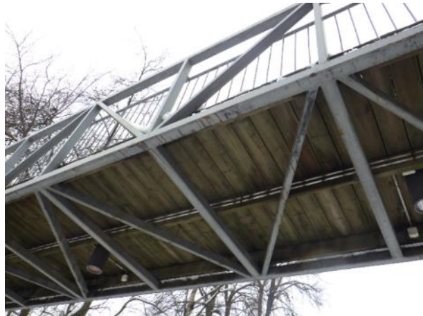
Yleiskuva K-portaan teräsristikkosillasta. Sillan teräsrakenteissa on törmäysvaurioita, alkavaa teräskorroosiota ja maalin hilseilyä.
