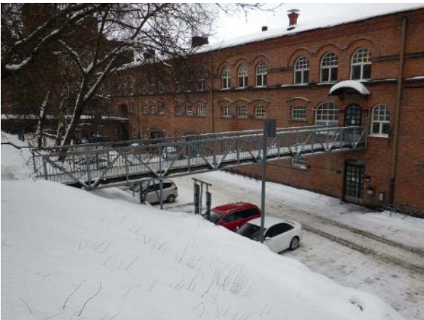
Yleiskuva K-portaan teräsristikkosillasta. Sillan teräsrakenteissa on törmäysvaurioita, alkavaa teräskorroosiota ja maalin hilseilyä.
