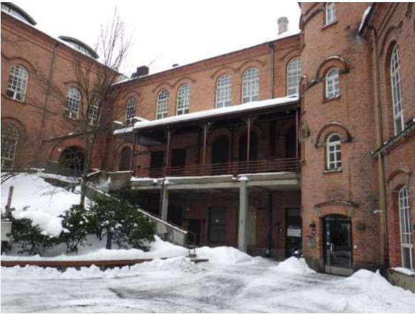
Yleiskuva teatterin sisäänkäynnin edustalla olevasta kansirakenteesta. Kannessa havaittiin vesivuotoa.
