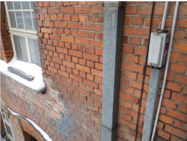
Paikallisesti vaurioituneita tiilisaumoja.
