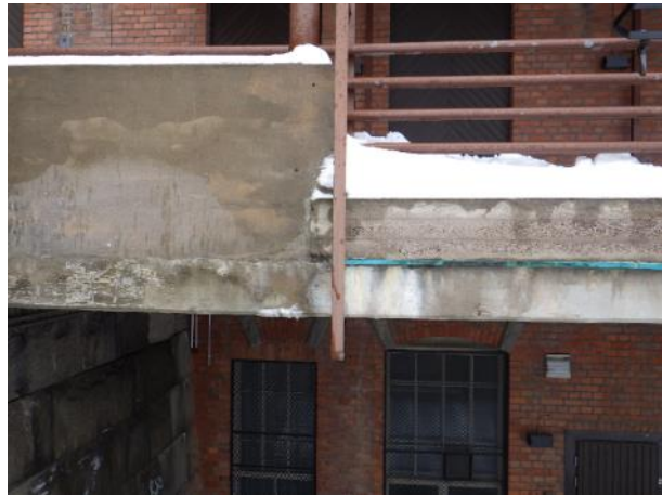
Yleiskuva teatterin sisäänkäynnin edustalla olevasta kansirakenteesta. Kannessa havaittiin vesivuotoa.
