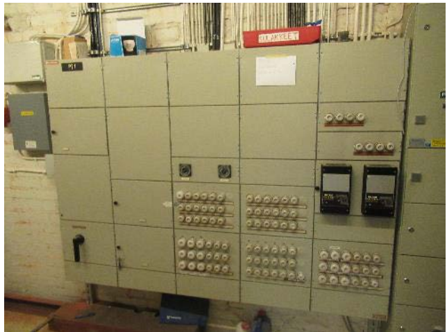
Vanhoja sähkökeskuksia Frenckellin IV-konehuoneessa ja sähkötilassa. Keskuksissa on tehty PEN-yhdistys.
