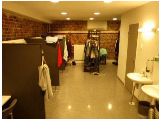
Yleiskuvia pohjakerroksesta. Kuvissa näkyy massiivitiilimuurattuja kantavia rakenteita.
