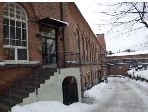
Yleiskuva (vas) puistosiiiven viereiseltä kulkuväylältä. Rakennuksen sisäänkäyntien yhteydessä on betoni- ja kivirakenteisia portaita sekä metallirakenteisia kaiteita ja lippoja. Kuva betoniportaassa on paikallisia vaurioita. Kuvan taustalla näkyy L-portaan teräspalkkisilta. Oikeassa kuvassa sillan edustalla oleva katos, jonka puurakenteisten kaiteiden ja alakaton maalipinnat ovat kuluneet.
