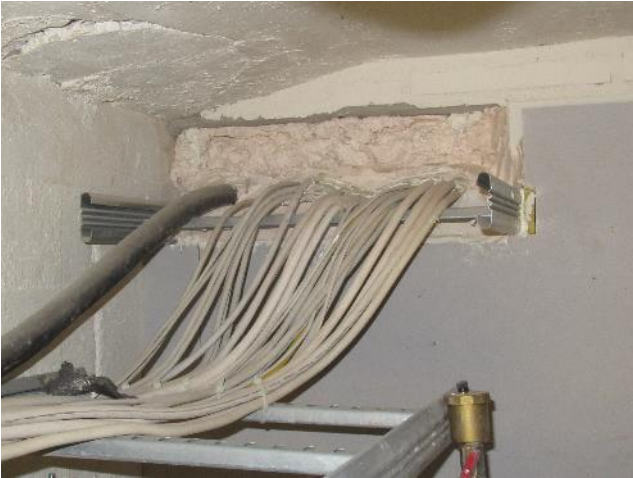
Hyvin tiivistetty läpivienti.
