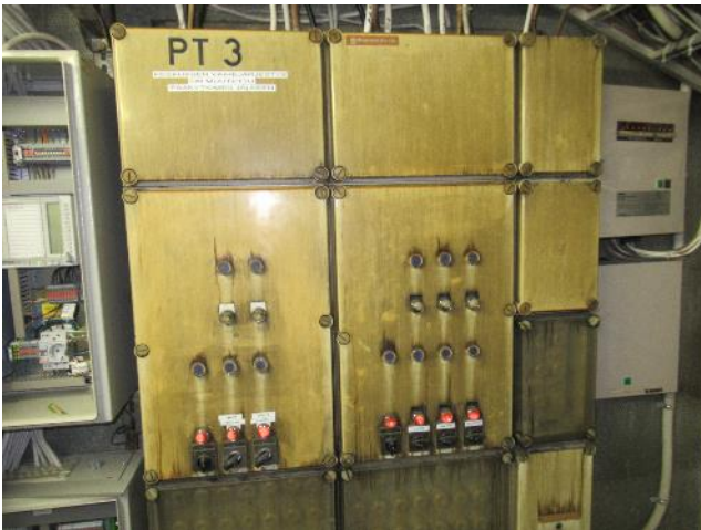
Vanhoja sähkökeskuksia Frenckellin IV-konehuoneessa ja sähkötilassa. Keskuksissa on tehty PEN-yhdistys.
